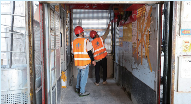
开展安全检查，筑牢安全红线
