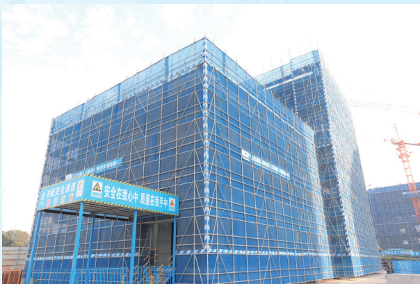
采用盘扣式脚手架，安全可靠
