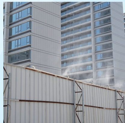
安装喷淋系统，防治扬尘污染
